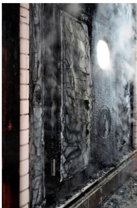
Abb. 2 Brandseite der Tür nach der Brandprüfung
